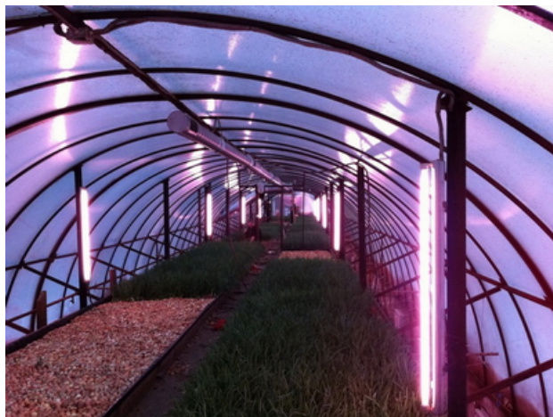
Рисунок 1.3 – Установка люмінесцентних ламп в теплиці
